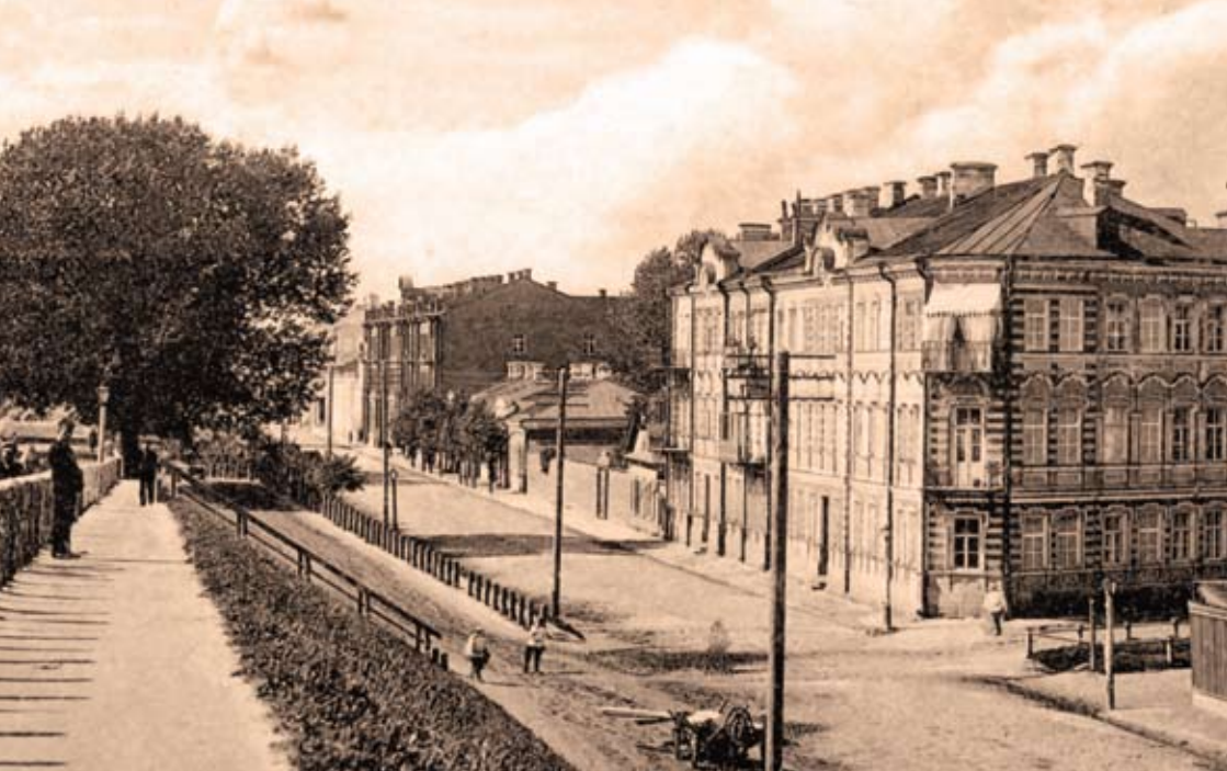
Schosejas Straße (Anfang des 20. Jahrhunderts, 18.novembra Straße)
